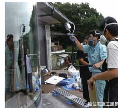
一般住宅施工風景
